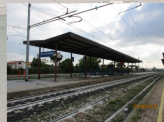
Le banchine non sono adeguatamente attrezzate per l'utenza
